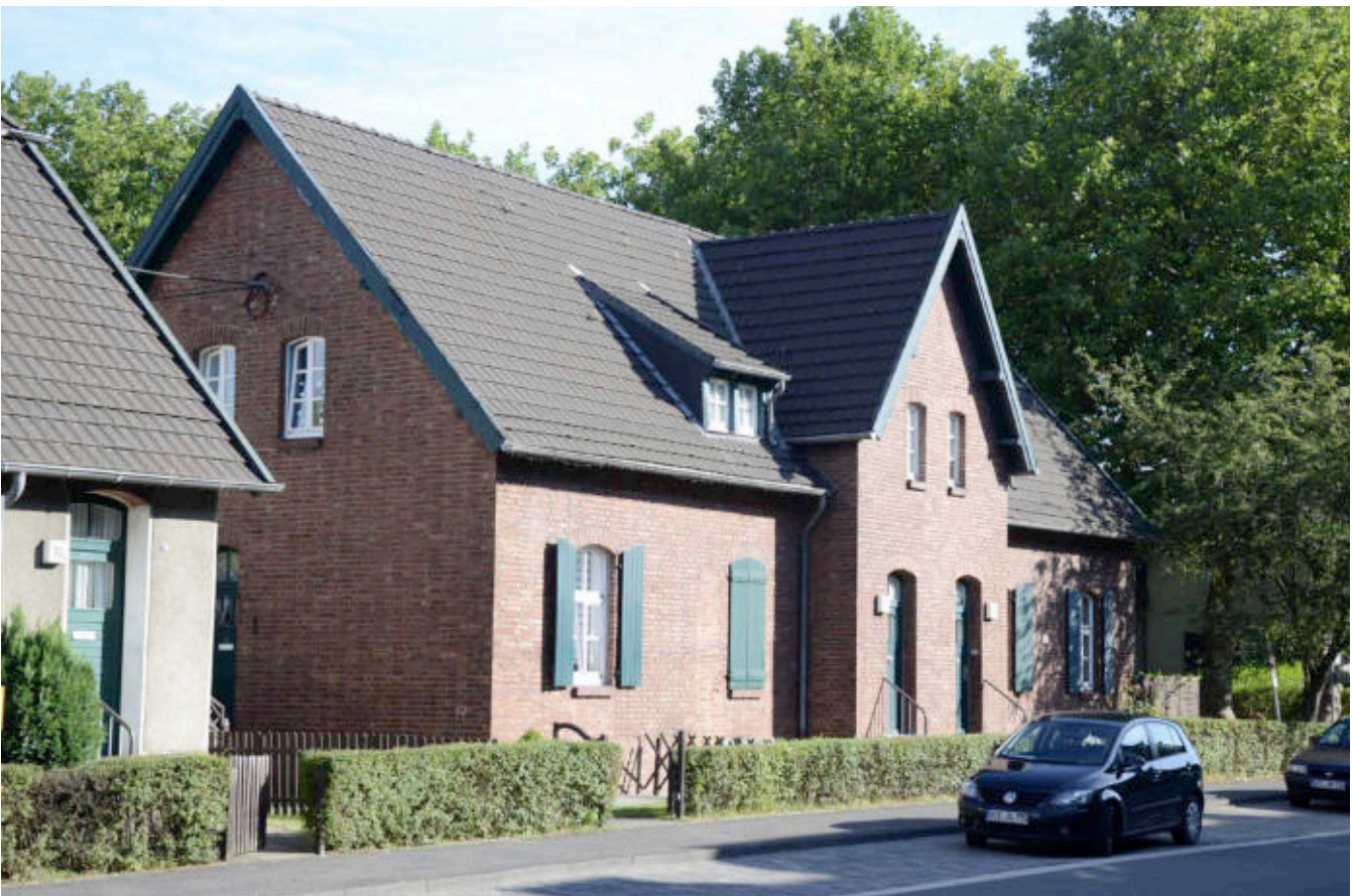
Abb. 40: Erhaltung und Sicherung bestehender Qualitäten in der Sanierung
